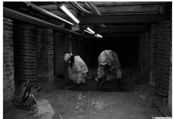
図4 本館床下調査状況（東から）
