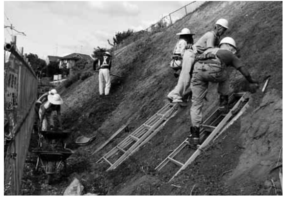
図4 調査風景（南から）
