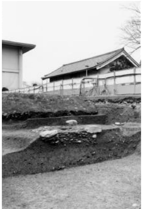
3 建物2112地業状況（北西から）
