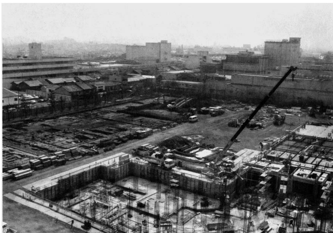
2 5区全景（西北から）
