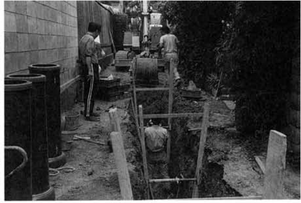
3 同 調査風景（北から）
