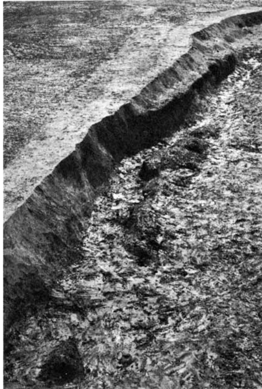
Fig. 25 SD25 東肩崩落状態
