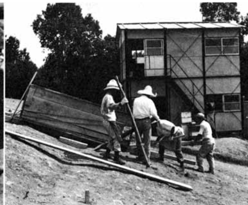
Fig. 42 取り上げ工程 (18)
