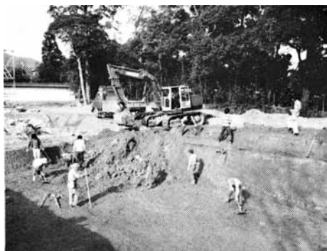
挿図 5 近世整地土層の重機掘削 (南西から)
