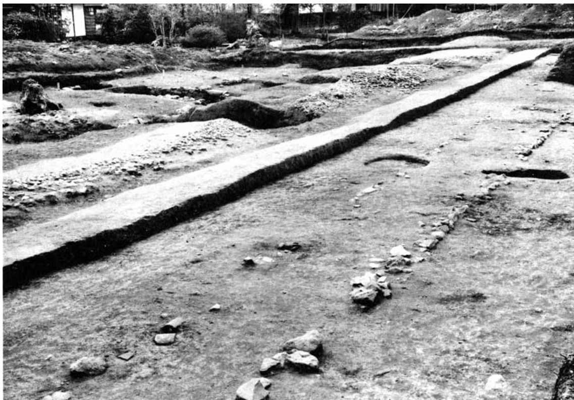
1 北トレンチ SA15、SX16、SC20(北東から)
