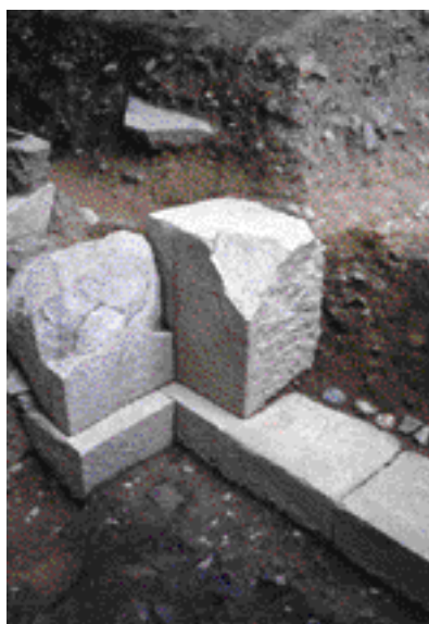
写真2 南面階段と基壇地覆石
