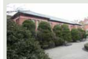
⑦ 同志社大学致遠館 大正5年(1916) 未指定 (上京区今出川通鳥丸東入玄武町)
