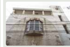
⑲ 旧京都中央電話局西陣分局 大正10年(1921) 重要文化財 (上京区油小路通中立売下る甲斐守町)
