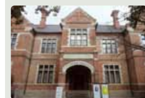
④ 同志社大学ハリス理化学館 明治23年(1890) 重要文化財 (上京区今出川通鳥丸東入玄武町)
