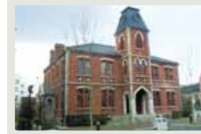
② 同志社大学彰栄館 明治17年(1884) 重要文化財 (上京区今出川通鳥丸東入玄武町)
