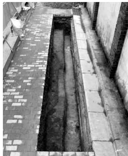
図43 A4区T2全景(西より)
