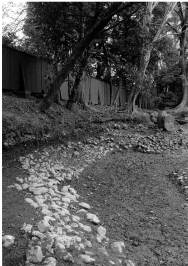
図 77 旧池南岸洲浜（北東から）
