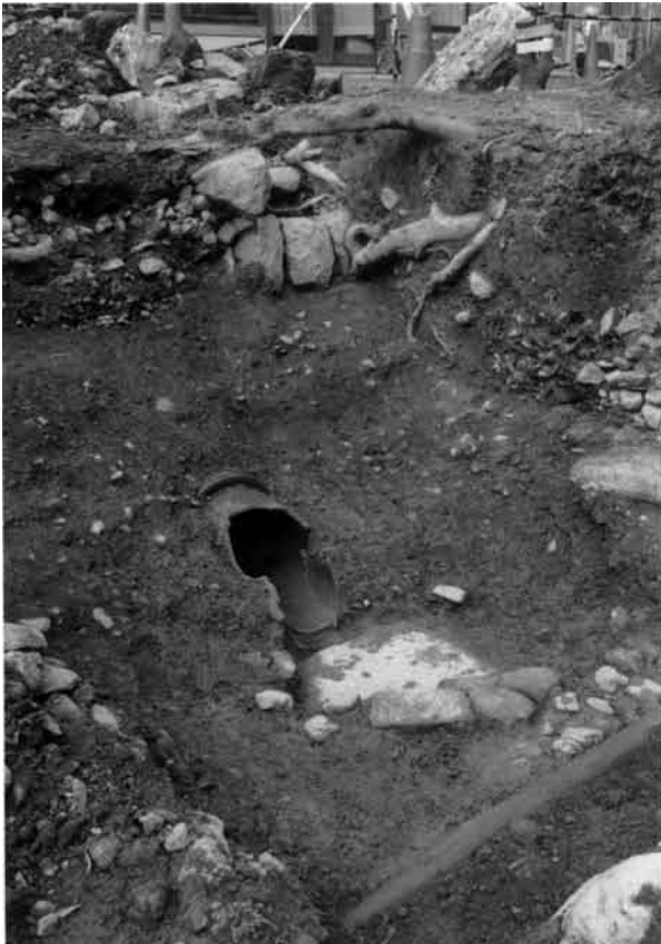
図75 11 トレンチ全景（南西より）
