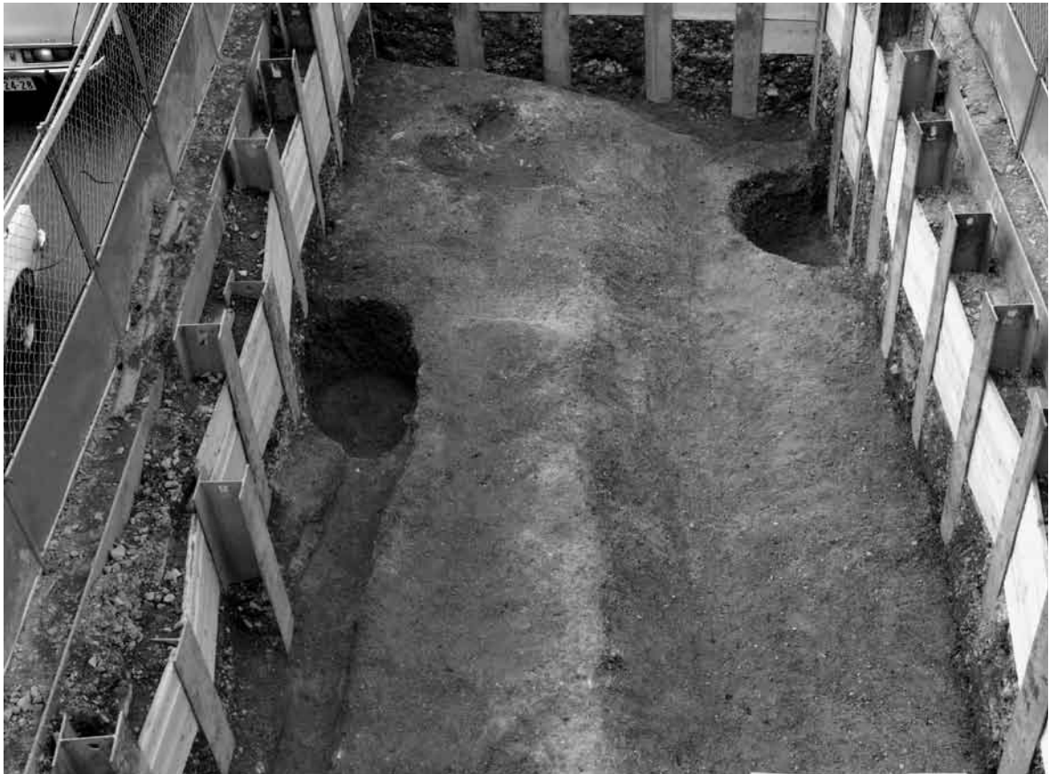
2 No.4 トレンチ全景 (東から)
