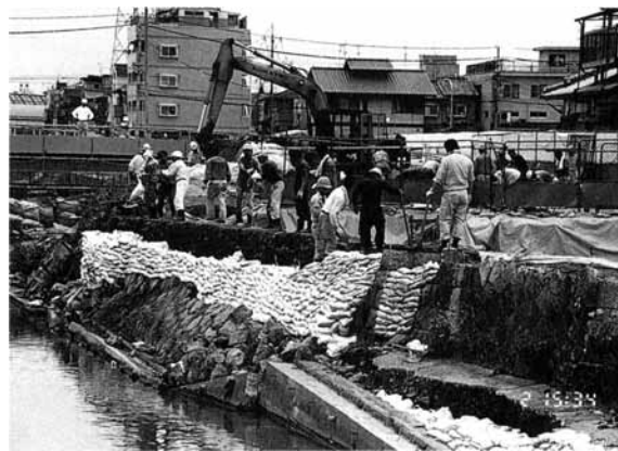
図 57 崩壊した護岸と土壌による応急修理
