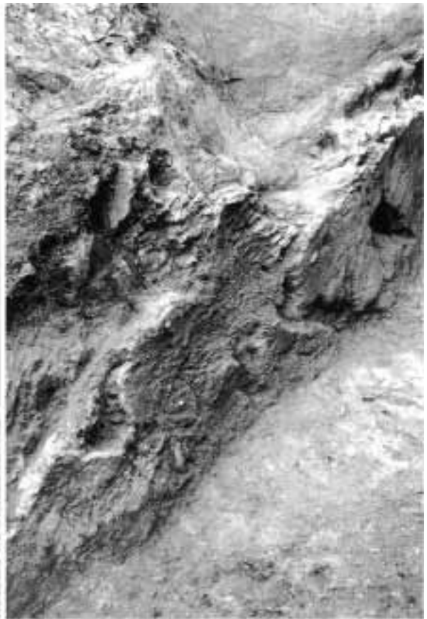
3 燃焼部南壁の補修痕跡（北東から）
