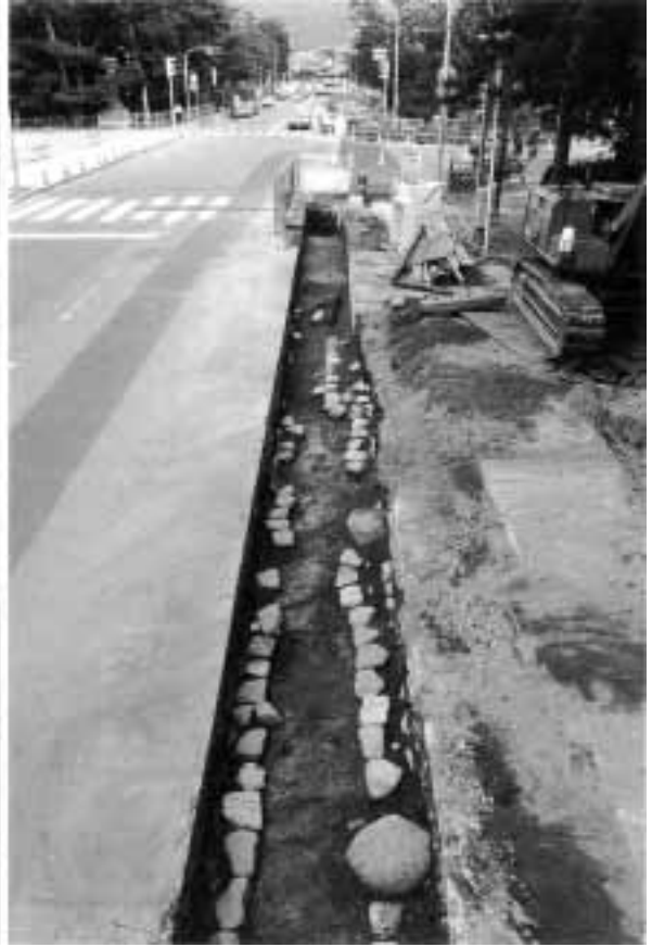
2 建物5 石組雨落溝（西から）
