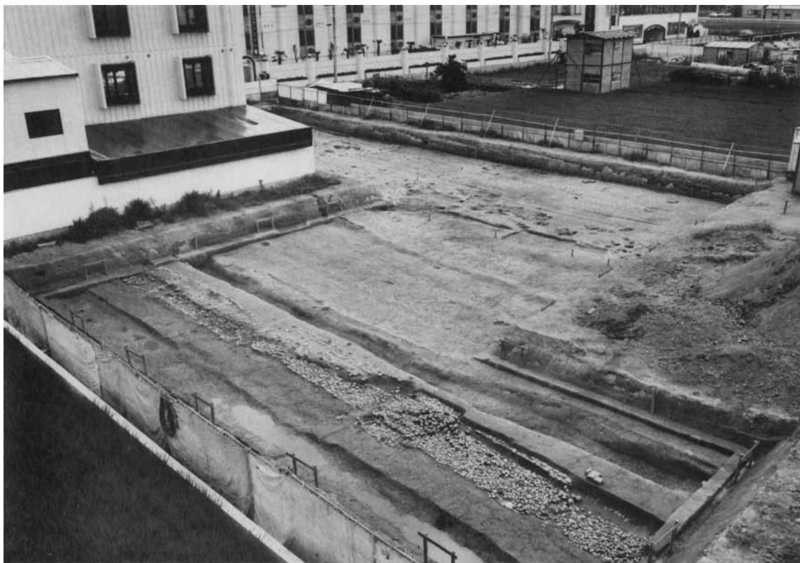
1 全景 (南西から)
