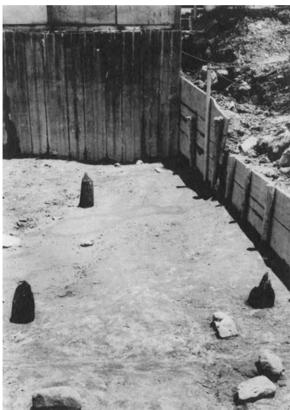
3 橋脚・SX18（西から）
