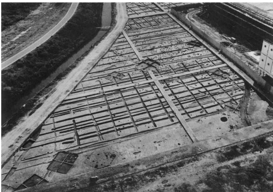
2 全景（北西から） 中央ブロック北半部
