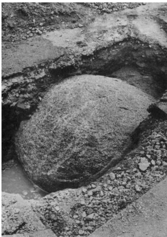
2 ガス管工事で出土した花崗岩（北東から）
