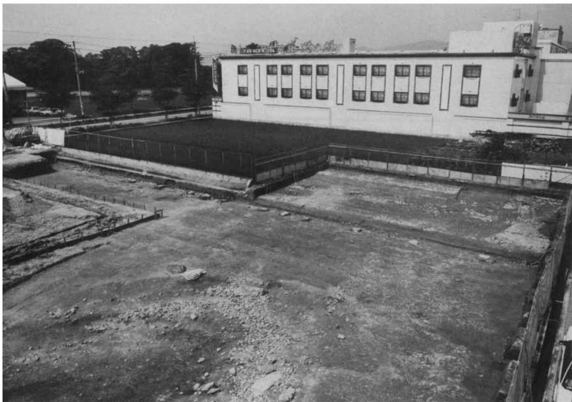
1 全景（北東から）
