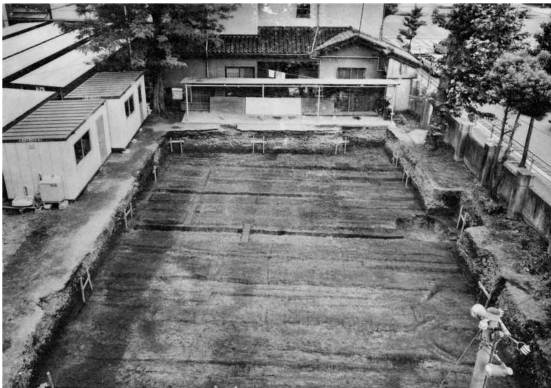
1 中・近世遺構面全景（西から）
