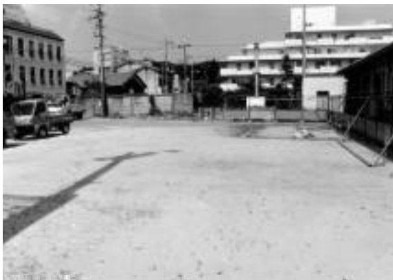
図2 調査前全景 (西から)
