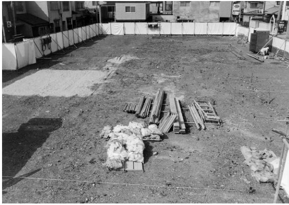
図4 調査前全景（東から）
