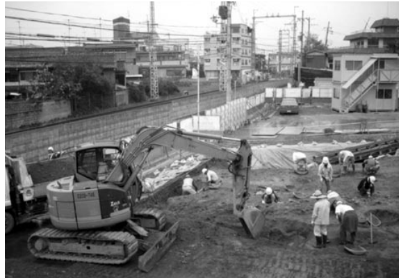
図3 2次調査作業風景（南西から）
