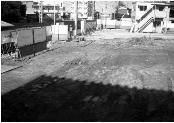
図2 2次調査前全景（南西から）
