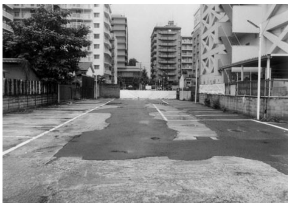
図1 調査前全景（北から）
