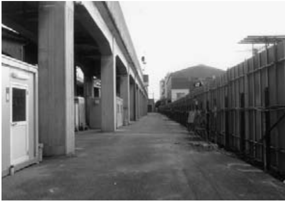
図 19 調査前全景（北から）
