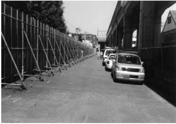
図9 調査前全景（南から）
