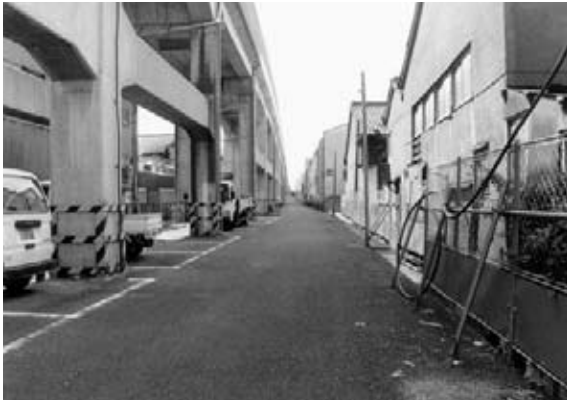
図 25 2区調査前全景（北から）
