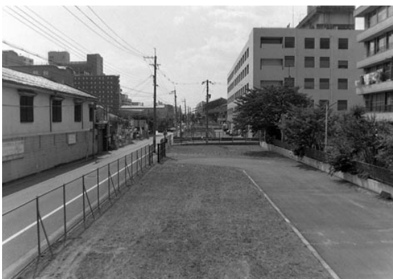
図1 調査前全景（東から）
