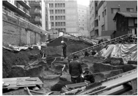
図4 作業風景（北から）
