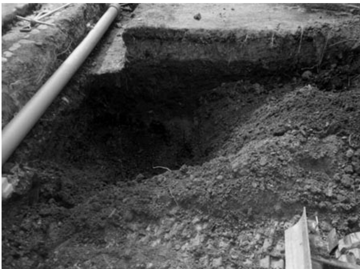
2 No. 23- 7地点 土壌1（北から）
