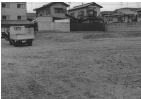
図2 調査前全景（東から）
