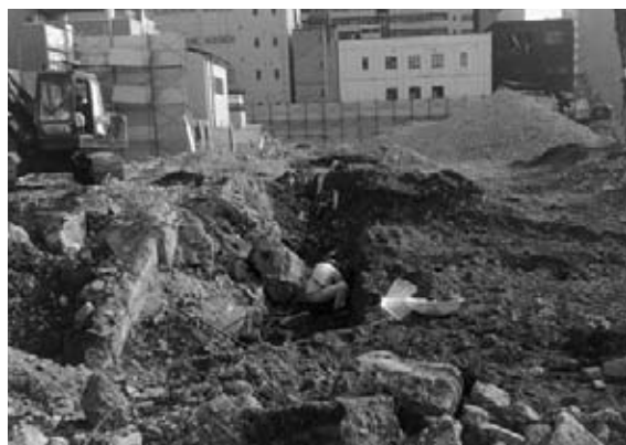
写真2 東校舎解体時の立会調査（北から）
