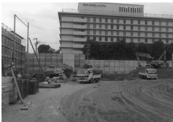
写真1 校舎解体風景（南から）
