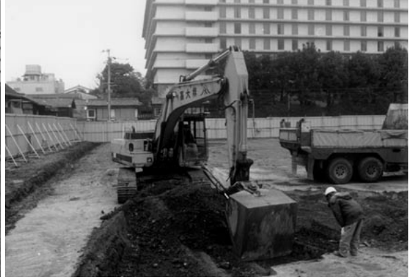
2 重機掘削（南から）
