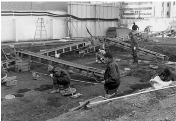
7 3区調査風景（北東から）
