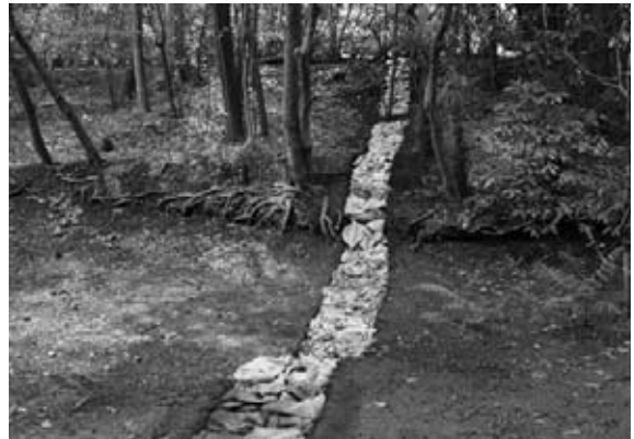
図6 6区埋戻し状況（北から）
