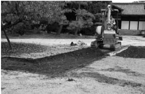
G区機械掘削（南西から）
