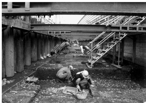
図3 作業風景（西から）
