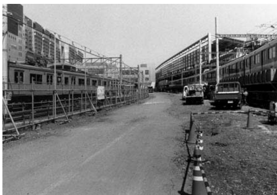
図2 調査前全景（西から）
