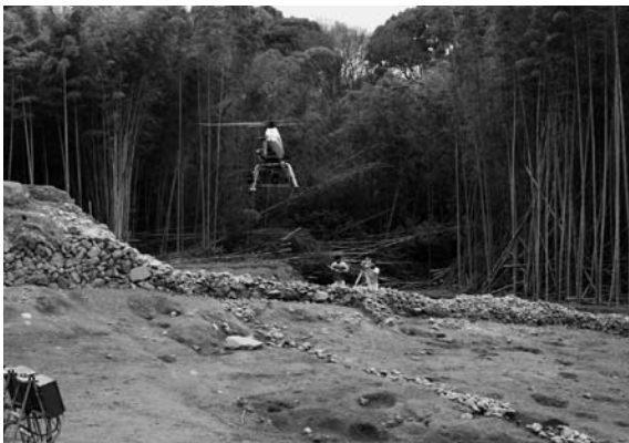
図8 1・2区ラジコンヘリ作業風景（南西から）
