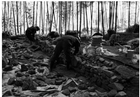
図15 石塁移築 復元作業風景（北西から）
