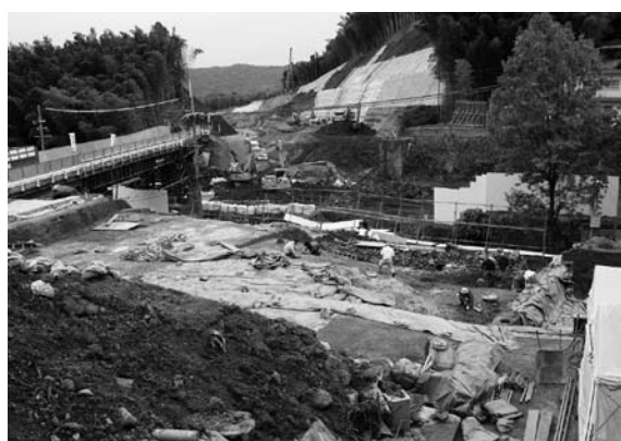
図13 7区作業風景（北西から）
