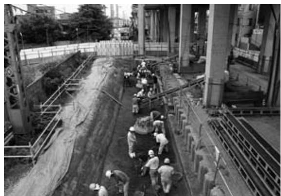
図6 掘削作業風景 C2区(南西から)
