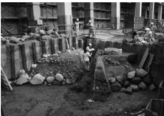
図5 測量作業風景 B3区(北から)
