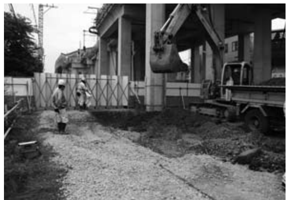
図4 重機掘削 C2区(南から)
