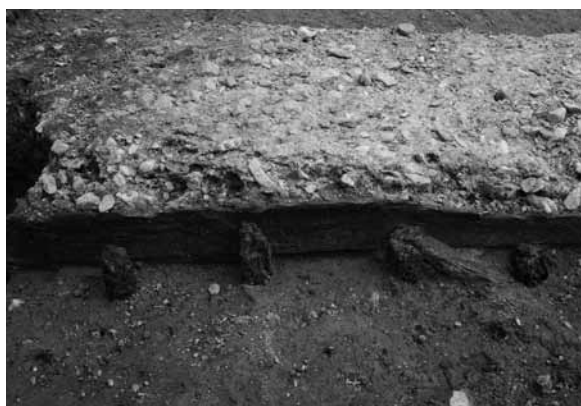
3 2区 土留79（西から）
