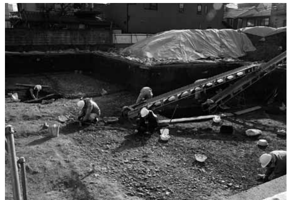
図6 2区 作業風景（北東から）
