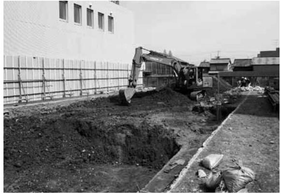
図5 重機掘削状況（西から）
