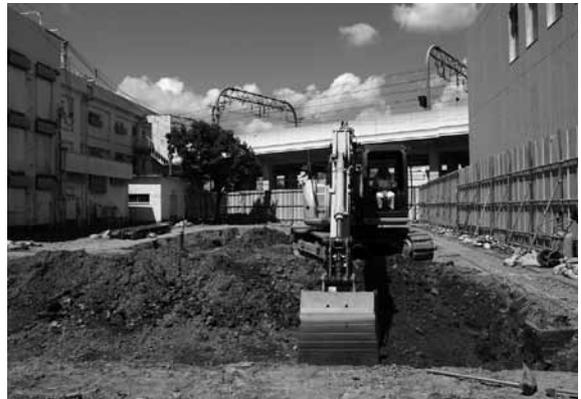
図9 重機による埋め戻し状況（東から）
