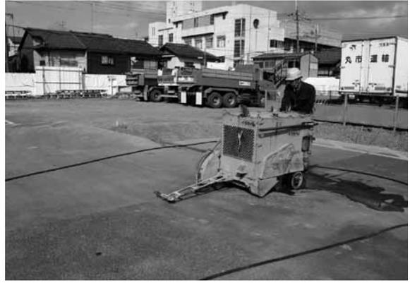
図4 アスファルトカッター工事（南東から）
