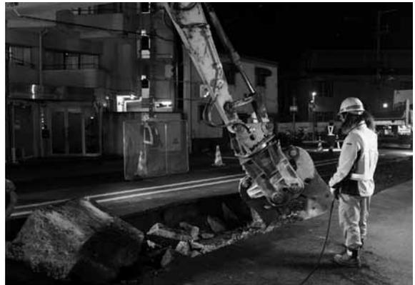
図12 E区軌道基礎撤去状況（東から）
