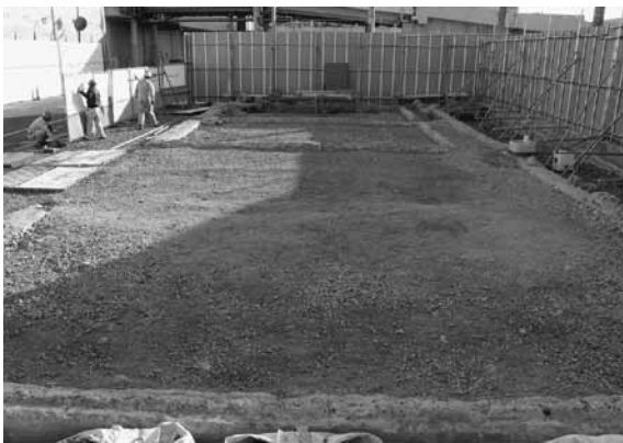
図7 3区調査前全景（北から）
