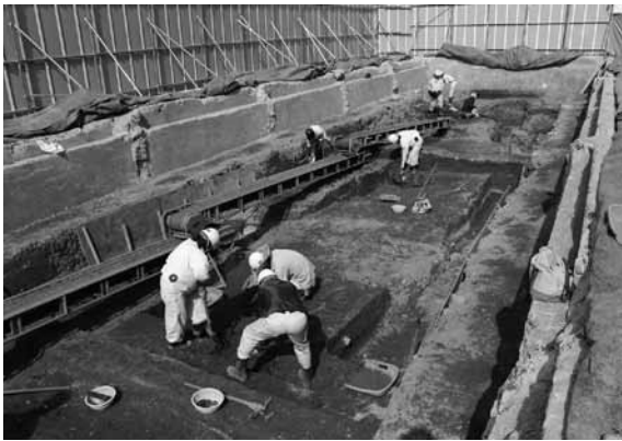
図5 1区作業状況（南東から）
