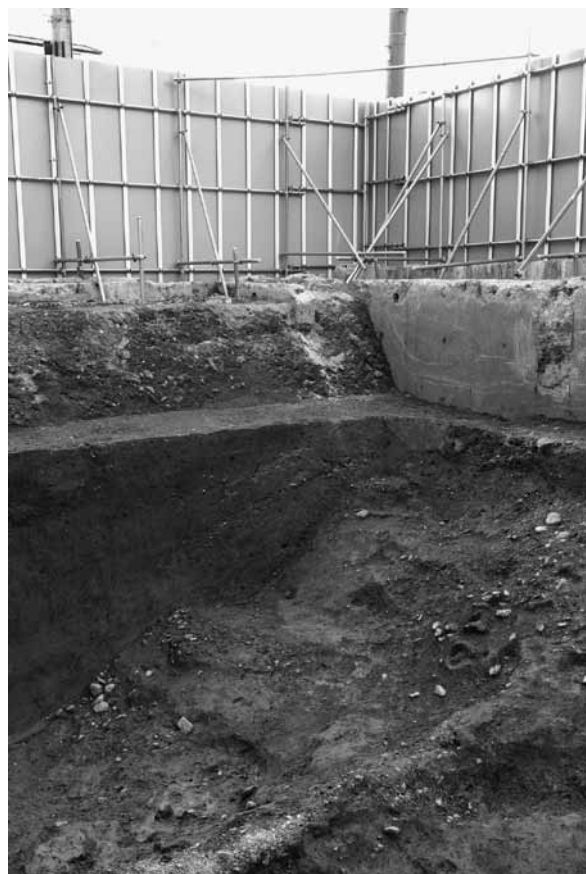
3 3区堀1西肩（北東から）
