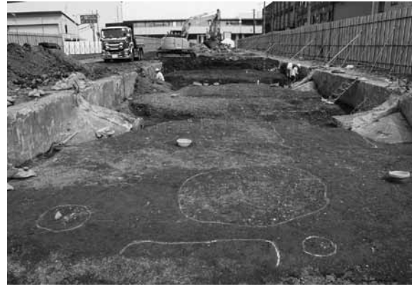
図4 1区重機掘削状況（西から）
