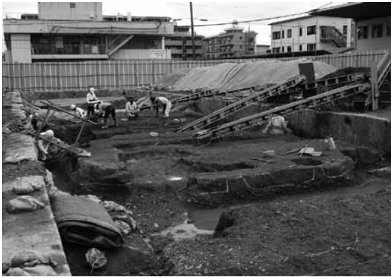
図5 1区作業状況（東から）
