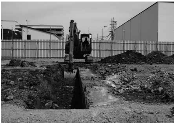
図7 2区重機掘削状況（南から）
