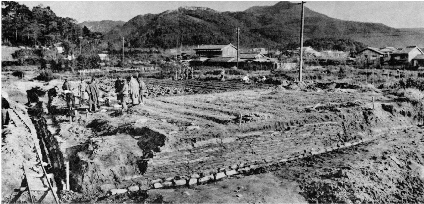
東方基壇発掘状況 1934年 西北より 基壇の様子
