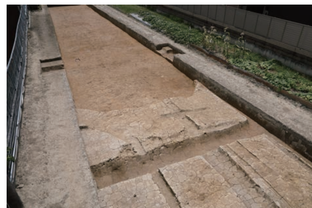
写真2 道路側溝20・34・40(北東から)
