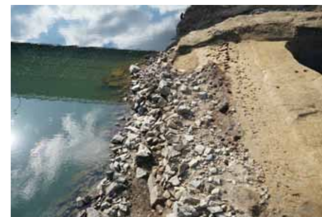
写真10 2区護岸2125(北から)
