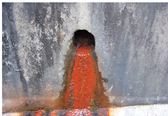
写真21 パイプ状ベンガラ原材料である鉄バクテリアの集積地状態
