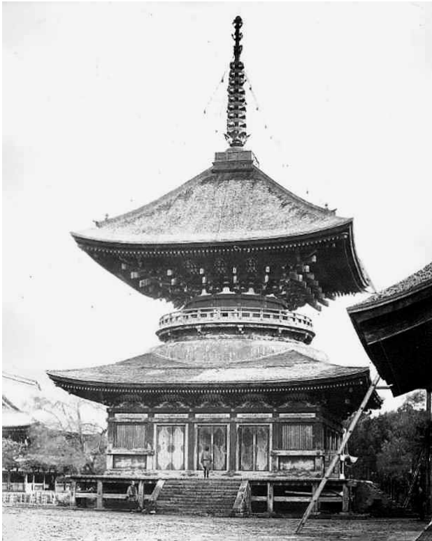
図19 鶴岡八幡宮大塔
