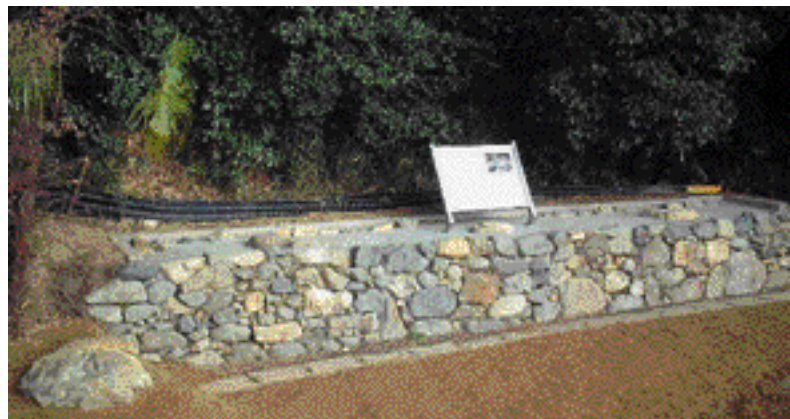
移築した景石(左)と石垣
