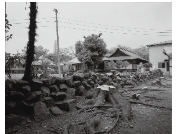
石塁 (南東から)
