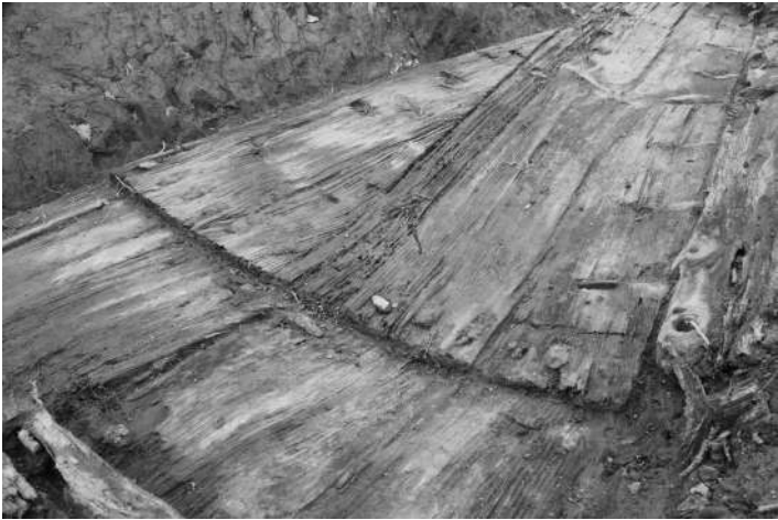
写真7 北端では通釘を用いて敷を前後継ぎする。継いだ敷は三角板と斜め板で構成される（南から撮影）
