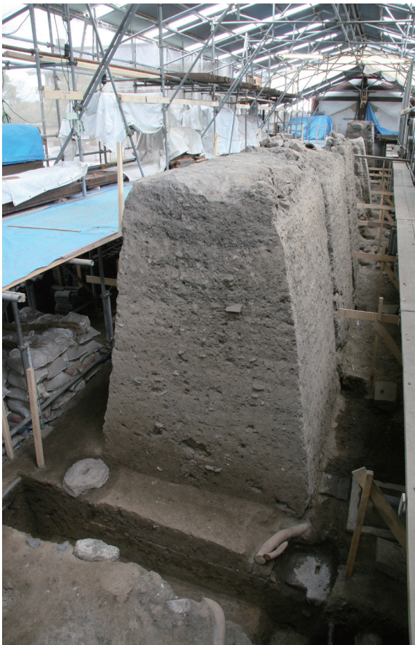
図4 東寺東築地断ち割り状況
