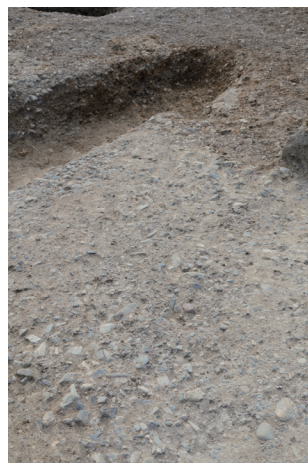
③九条大路路面（北東から）
