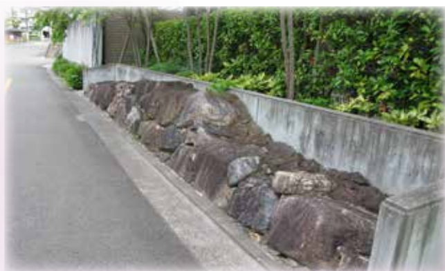
指月伏見城跡石垣（移築）
